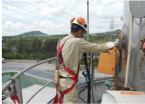
รูปที่ 85 การตรวจวัดคุณภาพอากาศจากปล่องระบายอากาศ
