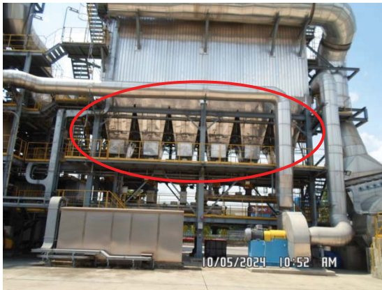
รูปที่ 9 ระบบดักฝุ่นแบบถุงกรอง (Bag Filter)
