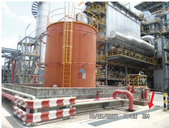
รูปที่ 29 รางระบายน้ำฝนปนเปื้อน
