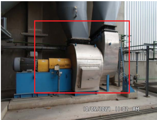
รูปที่ 15 พัดลมดูดอากาศ (Primary Air Fan) ของหม้อไอน้ำ
