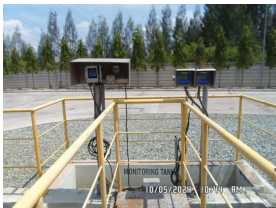
รูปที่ 37 เครื่องตรวจวัดคุณภาพน้ำทิ้งแบบอัตโนมัติ ก่อนระบายน้ำไปยังบ่อพักน้ำทิ้งที่ 1 และบ่อพักน้ำทิ้งที่ 2
