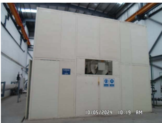
รูปที่ 21 Insulation บริเวณที่มีเสียงดัง
