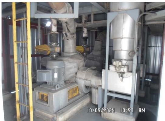
รูปที่ 7 ระบบควบคุม SO 2 และ HCl แบบ Dry-absorption System
